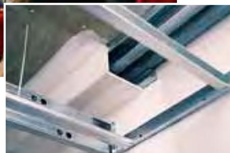
Fechamento de shaft e instalação do FGR.
